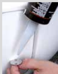
Photo du détail de la fixation « LOXX » collée (voir page 19 et 43).
