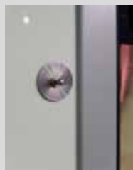
Photo du détail de la fixation « LOXX » collée (voir page 19 et 43).
