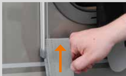
2) Faire glisser dans le rail vertical à partir du bas le jonc textile avec large bande velcro
