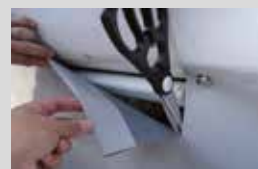
Entaille de l'accès de la porte, arrondir les bords
