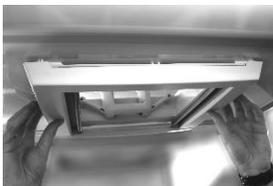
Verclipsen Sie den Plisseerahmen mit dem Montagerahmen. Orientieren Sie sich dabei an den Zentrierhilfen des Montagerahmens.
